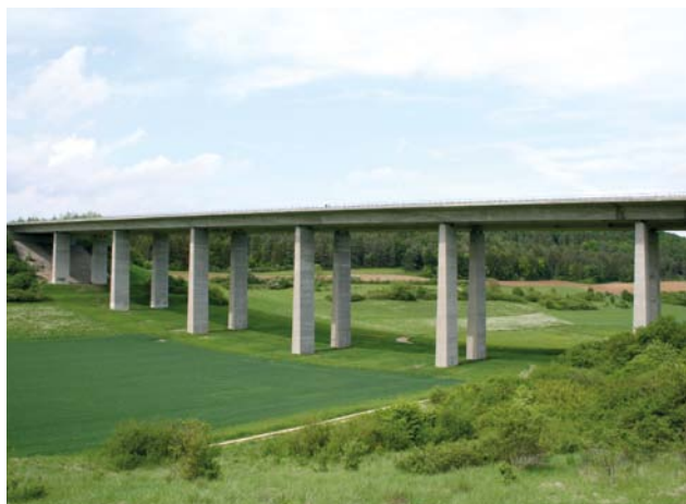
Fot. 74. Estakada zapewniająca ciągłość siedlisk płazów
