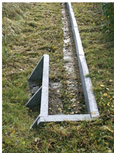
Fot. 19. Właściwe zakończenie ogrodzenia ochronno-naprowadzającego
