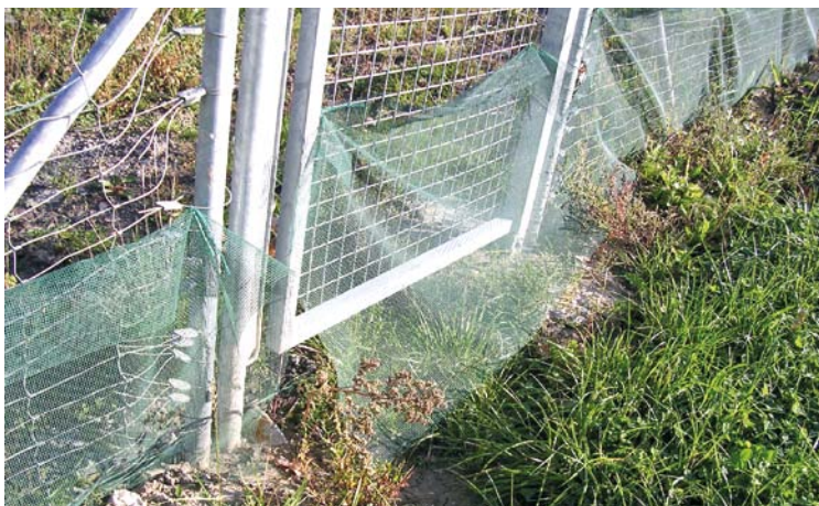
Fot. 49. Ogrodzenie z siatki polimerowej niedbałe połączone z ogrodzeniem dla dużych zwierząt
