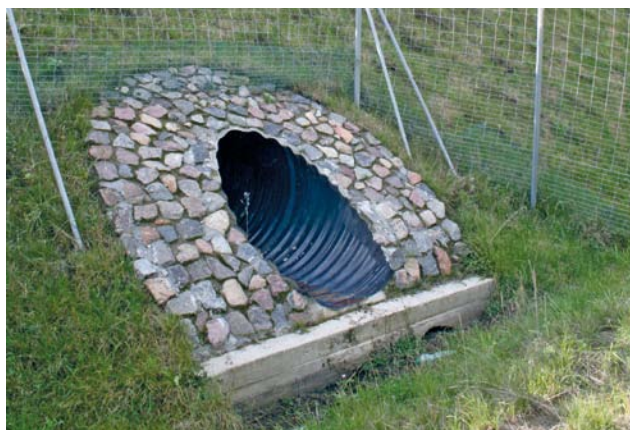
Fot. 91. Betonowy próg znacząco utrudniający płazom dojście do przejścia
