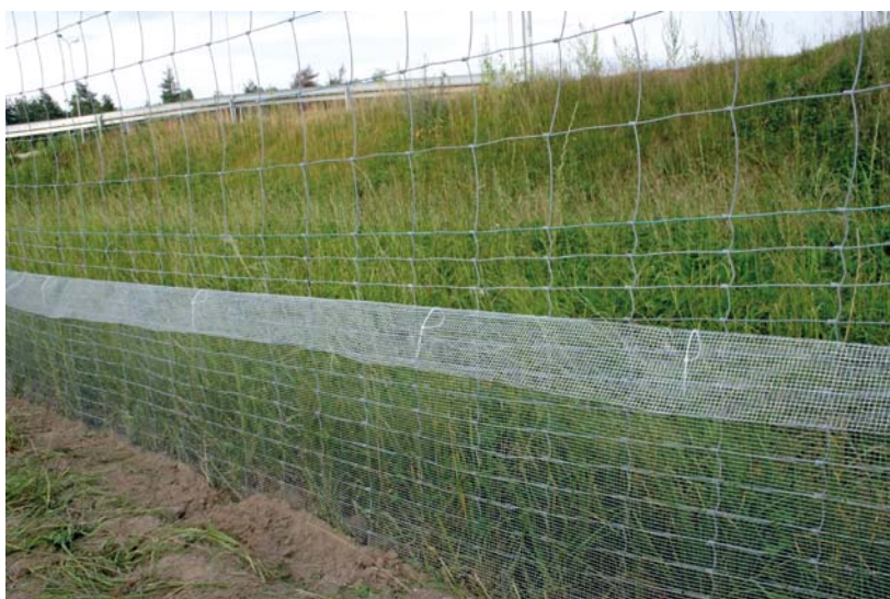
Fot. 21. Ogrodzenie ochronne wykonane z siatki stalowej
