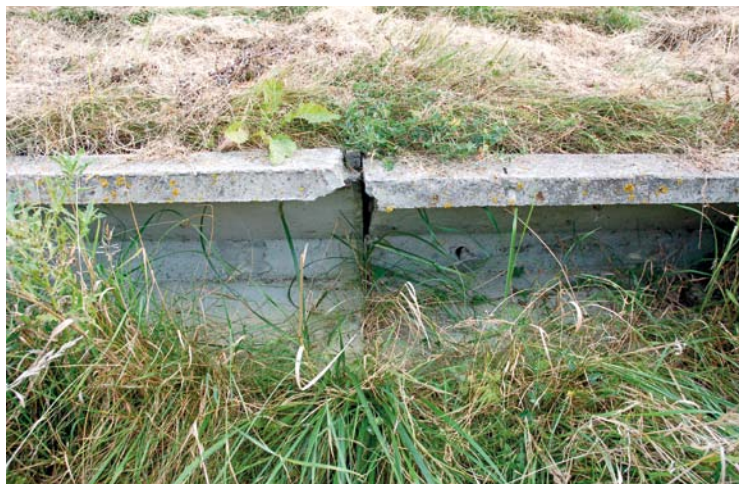
Fot. 41. Nieszczelności w ogrodzeniu betonowym powstałe w wyniku działania naporu gruntu oraz erozji wodnej
